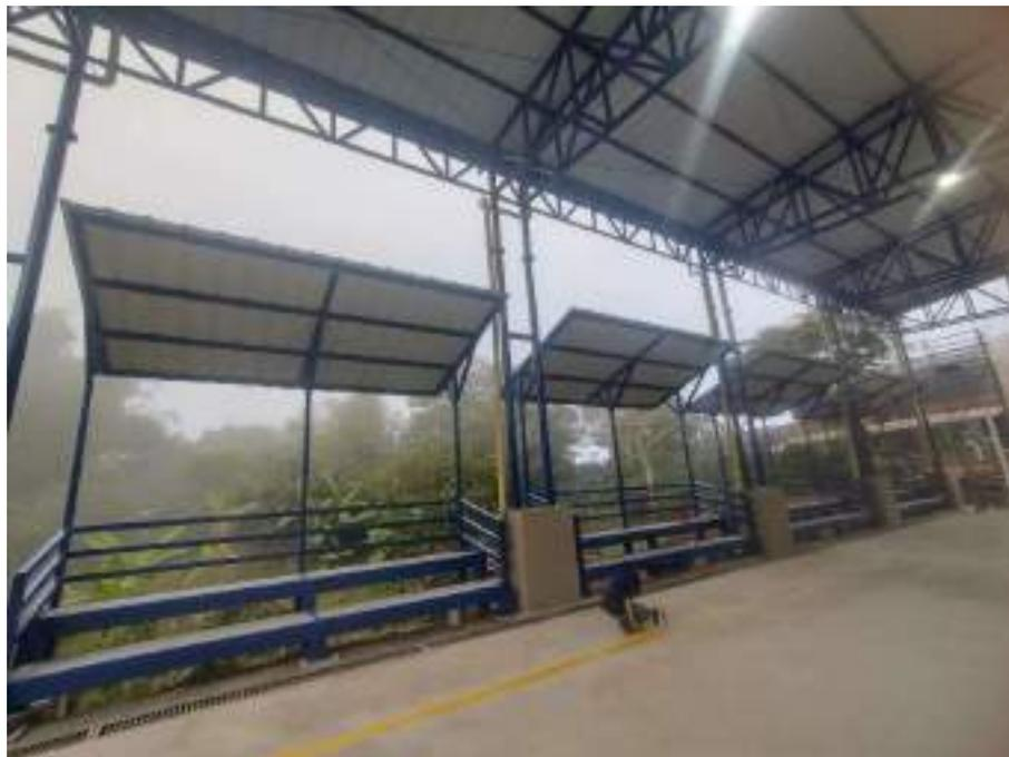
Imagen 6. Graderías en estructura metálica y losas en concreto
