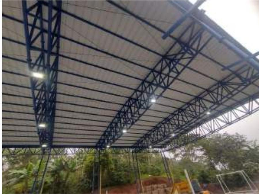
Imagen 9. Reflectores instalados
