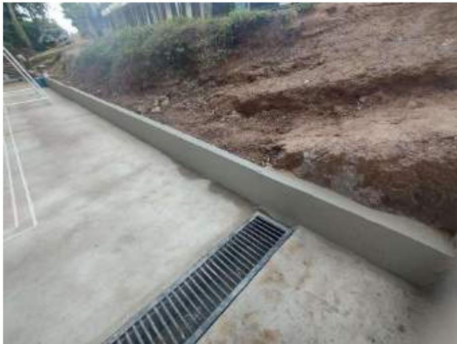
Imagen 14. Muro de confinamiento en concreto 3000PSI
