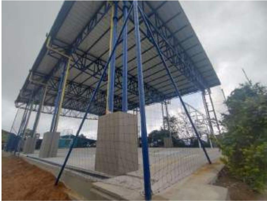
Imagen 25. Tubería metálica y malla de nylon para cerramiento
