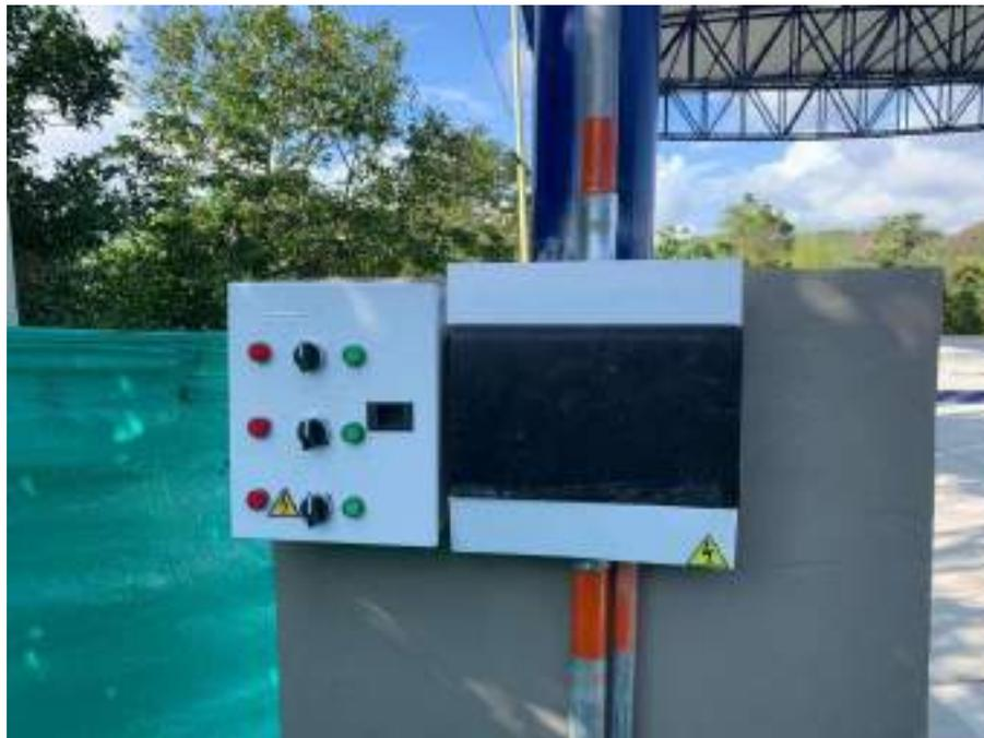
Imagen 20. Botonera de control de alumbrado y tablero eléctrico
