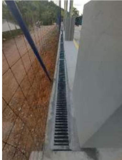
Imagen 19. Instalación de rejillas metálicas en cárcamos
