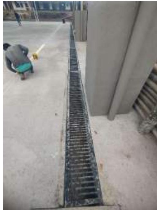
Imagen 8. Rejillas metálicas en cárcamos
