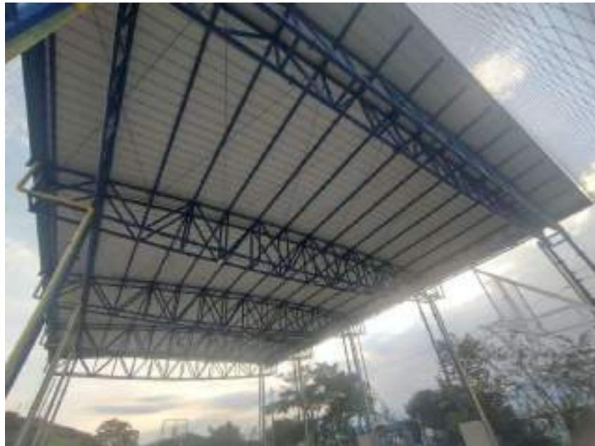
Imagen 18. Cubierta en teja standing seam
