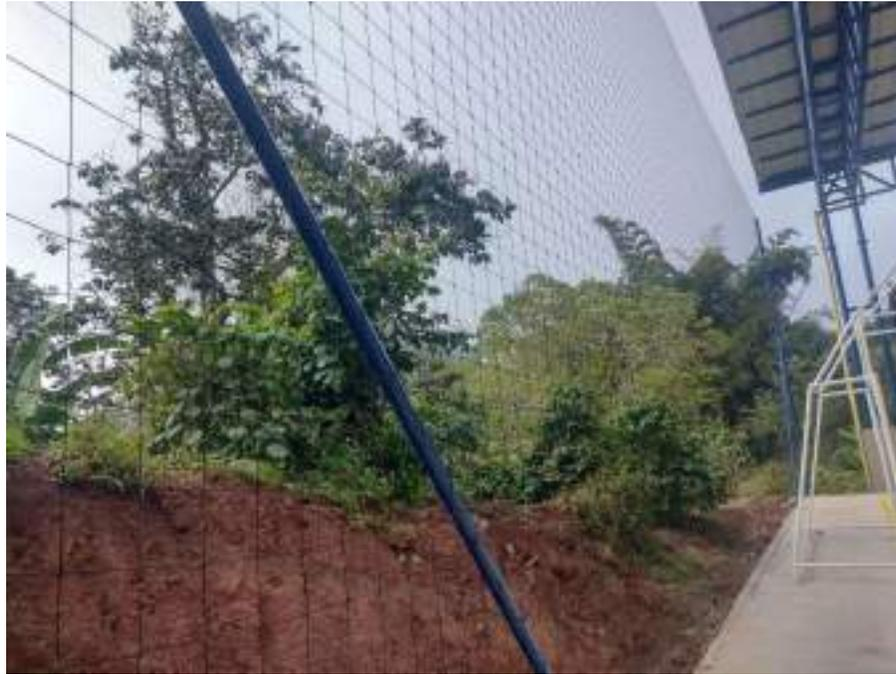
Imagen 13. Tubería metálica y malla de nylon para cerramiento
