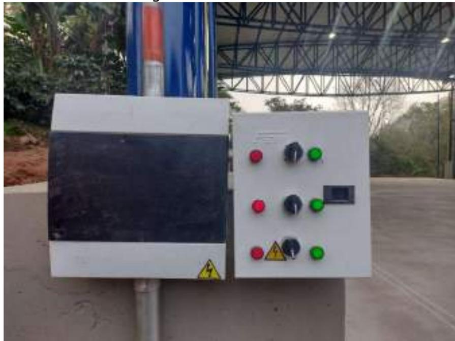
Imagen 10. Tablero de circuitos y botonera de control de alumbrado
